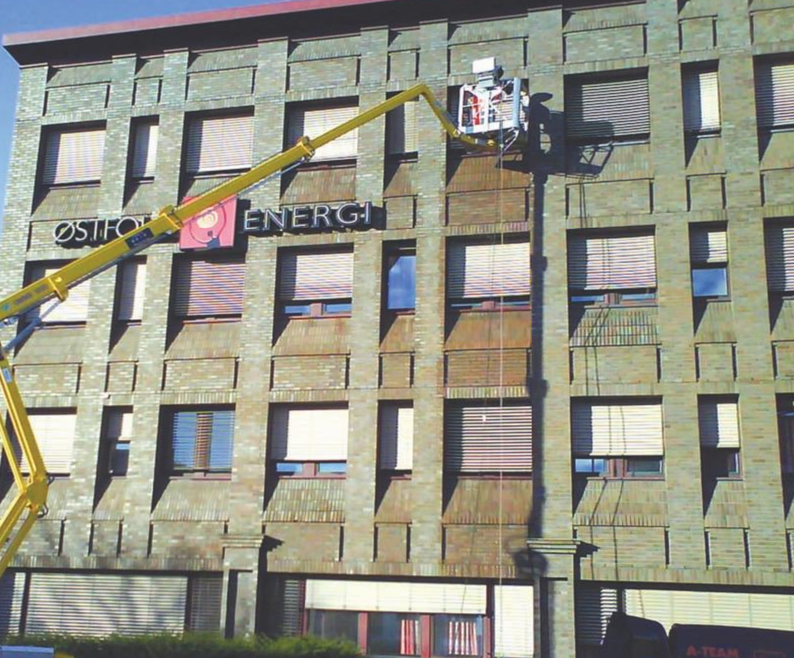
A-Team Gruppen har spesialisert seg på fasaderenhold. Vask med varig, smussavstøtende impregnering er noe av hemmeligheten. Blandingen lages etter en hemmelig, men miljøvennlig resept.
